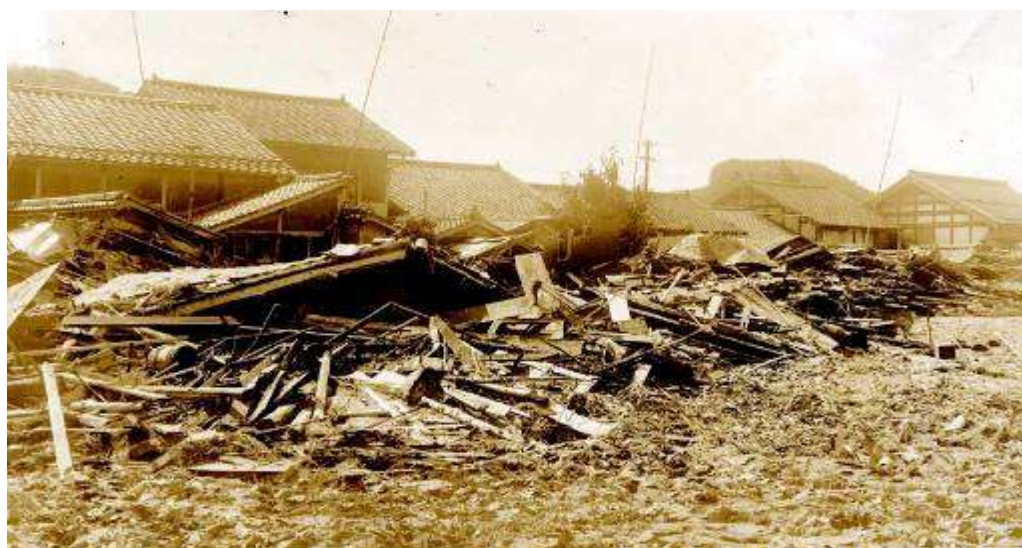
昭和18年9月洪水による 益田市街地の被災状況
